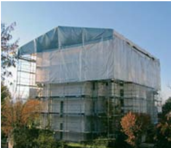
Das neue leichte Notdach aus Aluminium bewährt sich. The new light temporary roof made from aluminium, proves itself.
