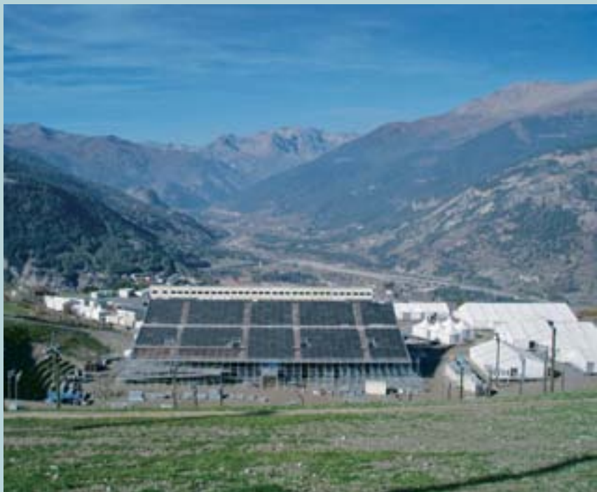
Sukzessive nehmen die temporären Bauten in Sauze d'Oulx Gestalt an. The temporary constructions are gradually taking shape in Sauze d'Oulx.
